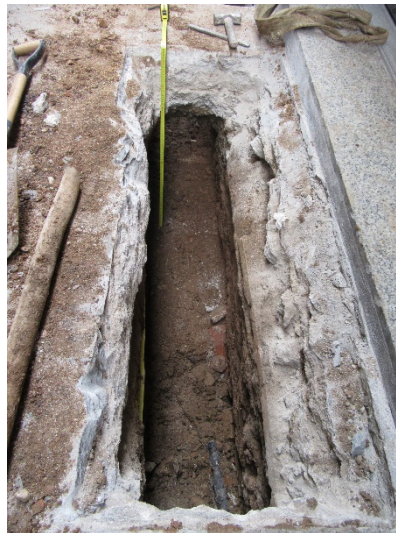
Foto 14. Final Rasa 1 a la finca núm. 33. Vista des del nord-est.
