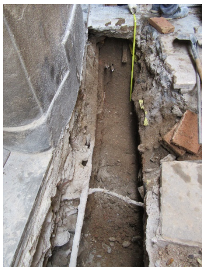
Foto 3. Final Rasa 1 a la finca núm.21. Vista des del sud-oest.
