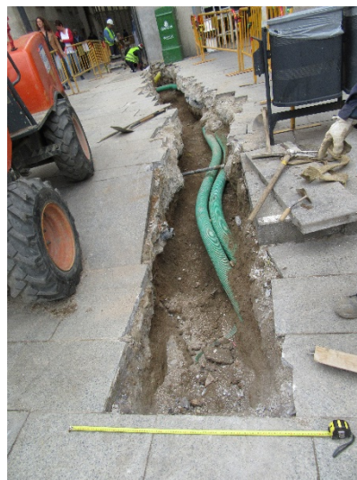
Foto 22. Final Rasa 1 a l'espai de la Plaça Nova i diversos serveis en ús Vista des del nord-est.
