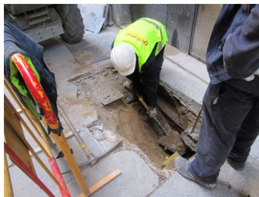
Foto 4. Excavació tram inicial Rasa 1. Vista des del nord-est.
