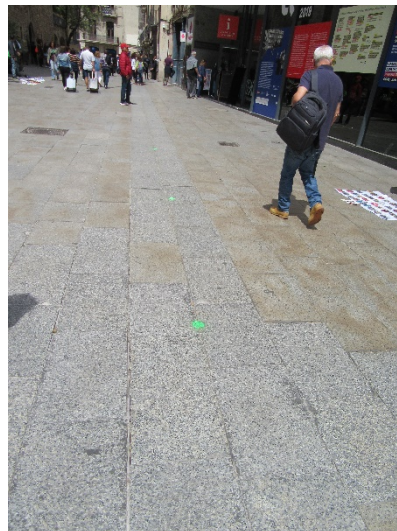
Foto 30. Inicial Rasa 2. Vista des de l'est.
