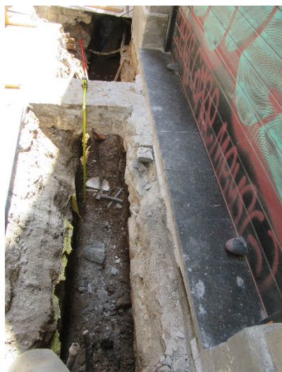
Foto 17. Final Rasa 1 a la finca núm. 37. Vista des del nord-est.
