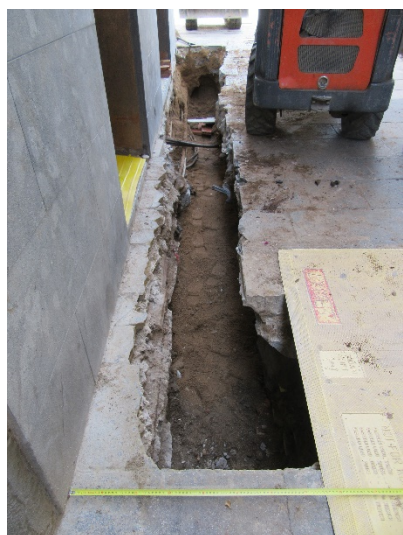
Foto 19. Final Rasa 1 a la finca núm. 39. Vista des del sud-oest.
