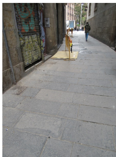
Foto 12. Inicial Rasa 1 a les finques núm. 33-35. Vista des del sud-oest.
