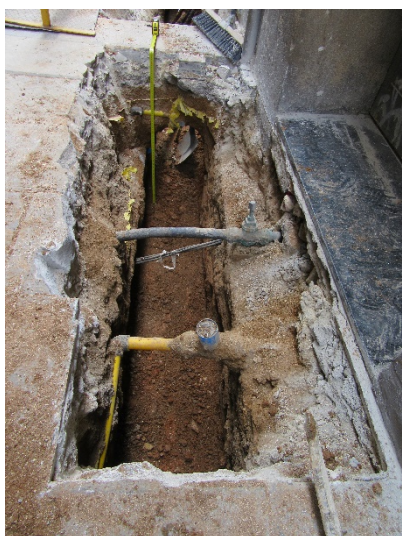
Foto 15. Serveis documentats (llum i gas), encara en ús, a la Rasa 1, finca núm. 33. Vista des del nord-est.
