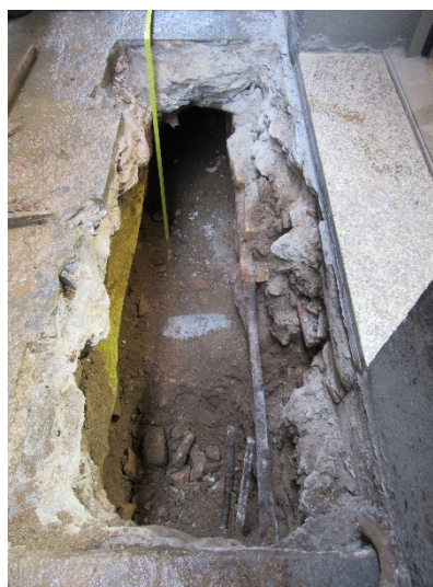
Foto 16. Final Rasa 1 a la finca núm. 35. Vista des del nord-est.
