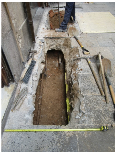
Foto 9. Final Rasa 1 a la finca núm. 27. Vista des del sud-oest.
