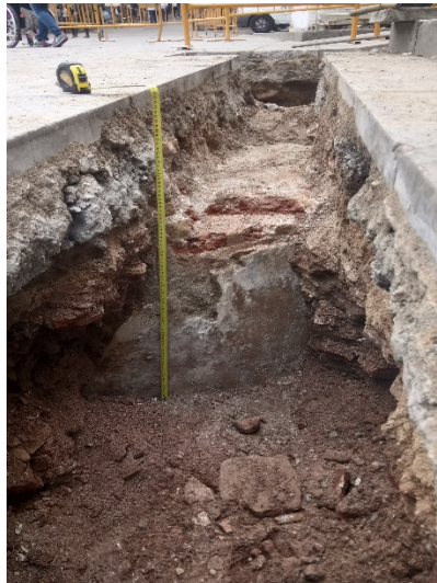
Foto 26. Mur UE 4. Vista des del nord-oest.
