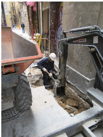
Foto 13. Excavació Rasa 1 a les finques núm. 33-35. Vista des de nord-est.
