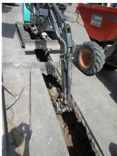
Foto 23. Excavació tram final Rasa 1 a la Plaça Nova. Vista des de l'est.
