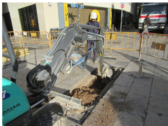
Foto 31. Excavació Rasa 2. Vista des del nord-est.
