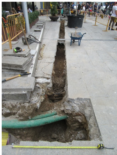
Foto 29. Final Rasa 1 a la Plaça Nova, núm. 3. Vista des del sud-est.
