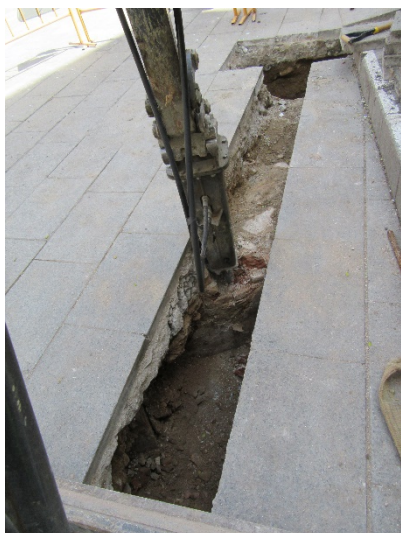
Foto 27. Desmuntatge parcial UE 4. Vista des del nord-oest.
