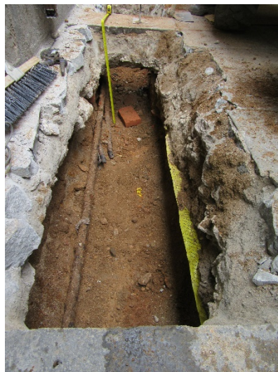
Foto 10. Final Rasa 1, a la finca núm. 29. Vista des del sud-oest.
