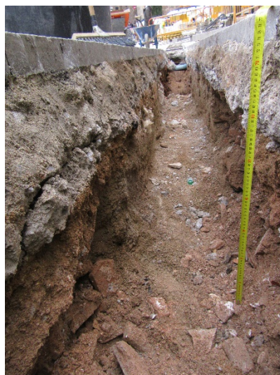
Foto 28. Tram final Rasa 1 a la Plaça Nova. Vista des del nord-oest.
