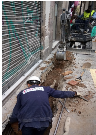
Foto 8. Excavació Rasa 1 a les finques núm 27-31. Vista des del sud-oest.
