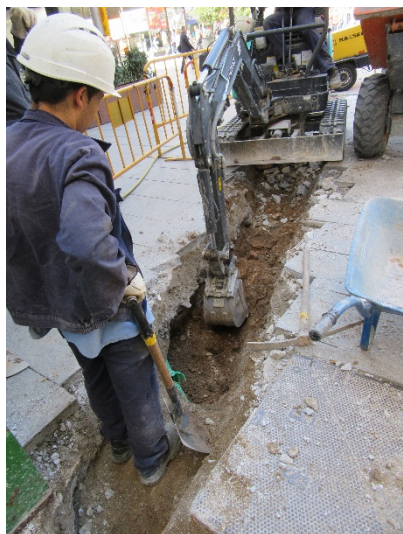
Foto 21. Excavació Rasa 1 a l'espai de la Plaça Nova. Vista des del sud-oest.
