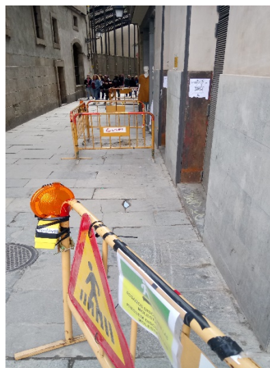
Foto 18. Inicial Rasa 1 a la finca núm. 39. Vista des del nord-est.
