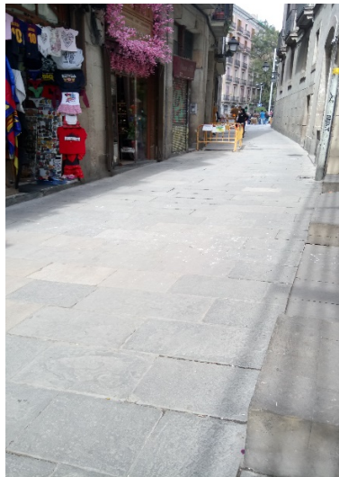
Foto 7. Inicial Rasa 1 a les finques núm. 27-31. Vista des del sud.
